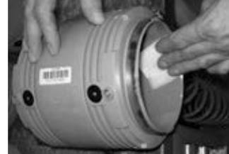
Muffe mit Tangit Reiniger (Code 799 298 023) reinigen
