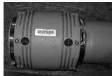
Muffe auf Rohr aufschieben
