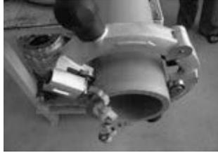
Oberste Schicht, (ein Durchgang) mit Schälwerkzeug abhobeln
