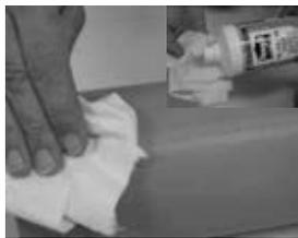
Rohr mit Tangit reinigen
